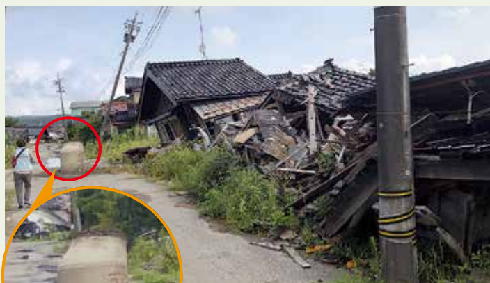
液状化で隆起したマンホール
